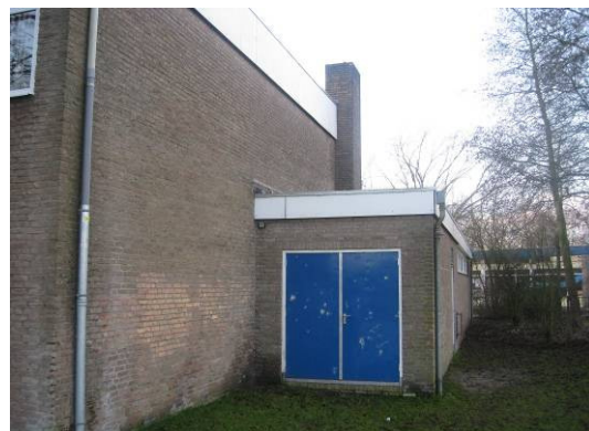
slecht voegwerk gevels
